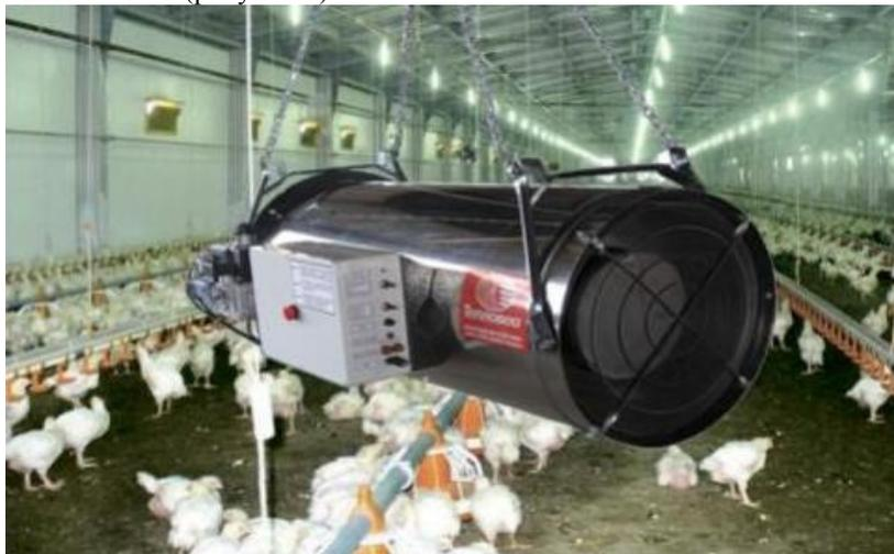
Рисунок 1. Обогрев помещения газогенераторами типа GP 95
